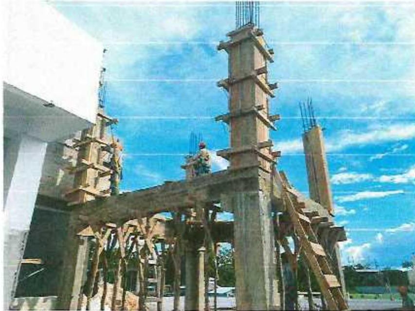
ENCOFRADO DE COLUMNAS DEL TANQUE ELEVADO
