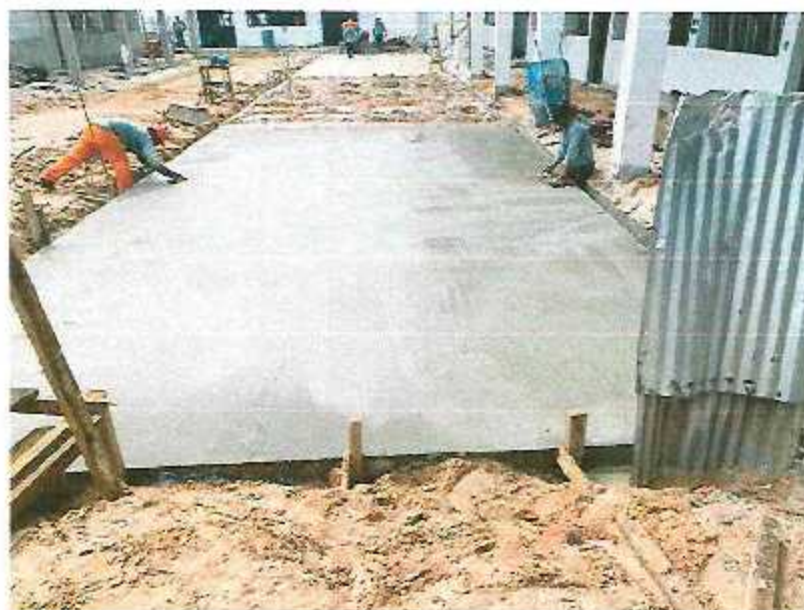
FROTACHADO - PATIO DE FORMACION
