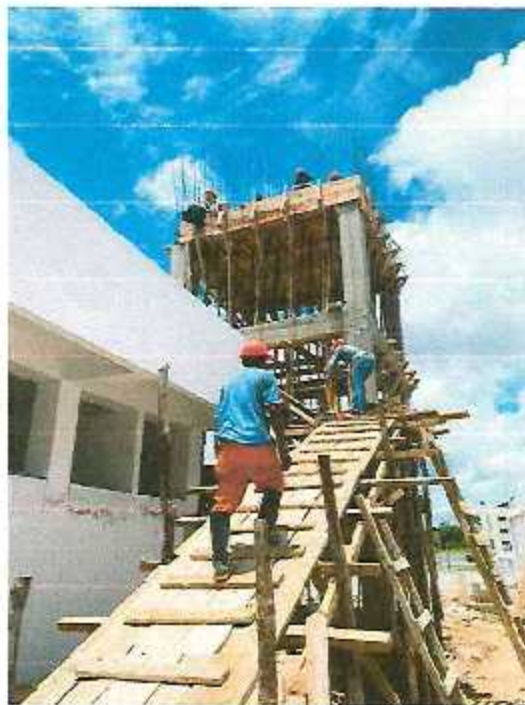
ENCOFRADO DE VIGAS Y LOSA DE TANQUE
