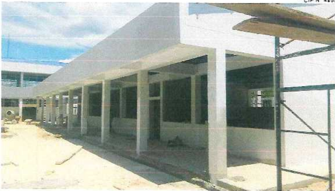
PINTADO DE COLUMNAS, VIGAS Y MUROS
