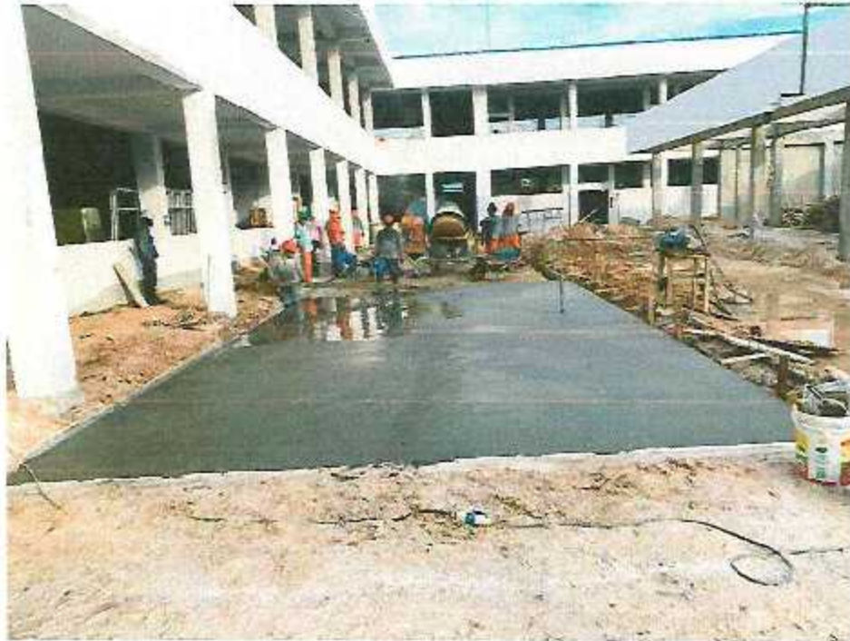
VACEO LOSA – PATIO DE FORMACION
