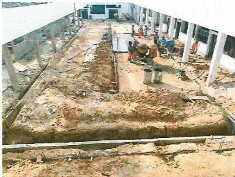
DESENCOFRADO DE CUNETAS
