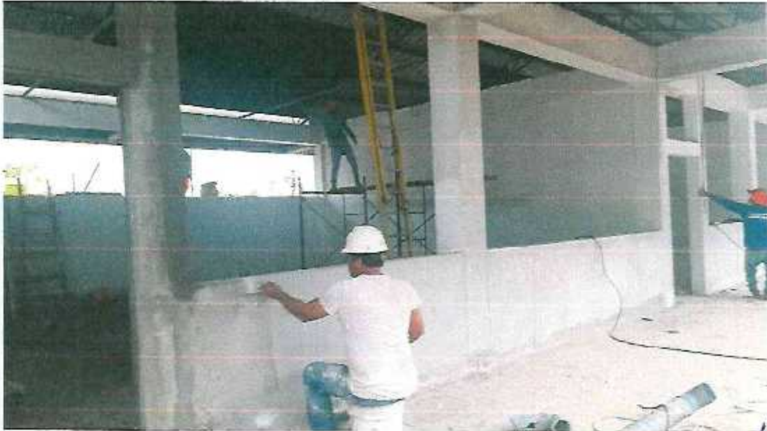
EMPASTADO DE MUROS Y COLUMNAS
